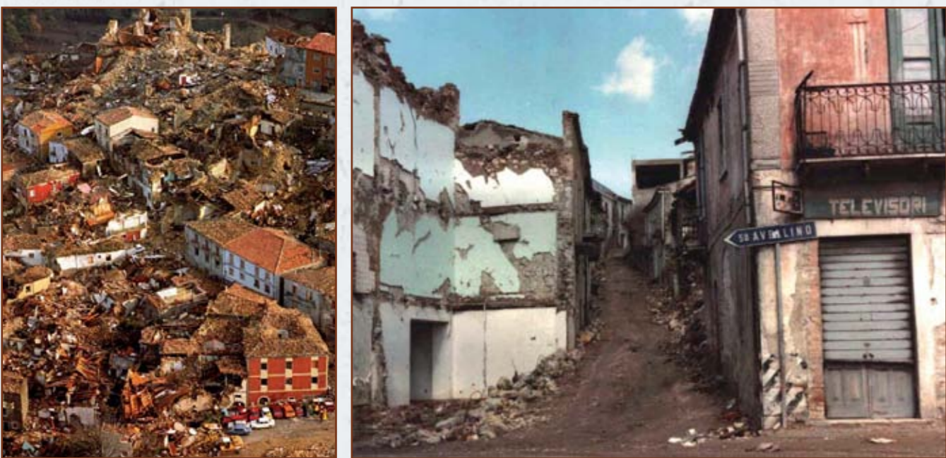
Alcuni esempi degli effetti prodotti dal terremoto del 23 novembre 1980 a Teora (a sinistra) e a Lioni (a destra), due dei paesi in provincia di Avellino maggiormente colpiti.
